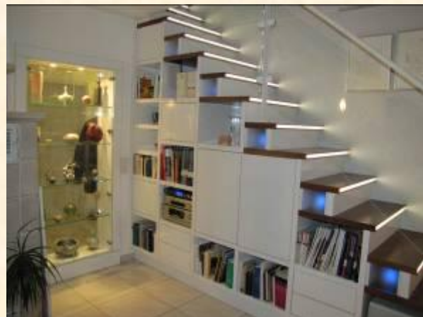
Treppenkonstruktion mit Unterbau und Beleuchtung
